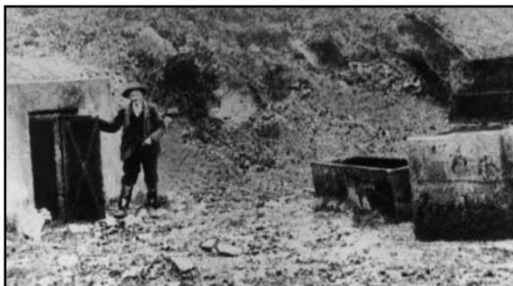
Gradnja vodnega zbiralnika nad Murovo (Fototeka GMI)
