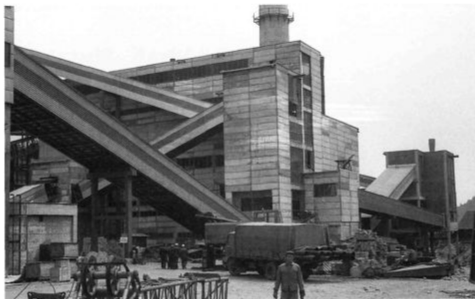
Izgradnja aglomeracije leta 1970 (fotoarhiv GM Jesenice)
