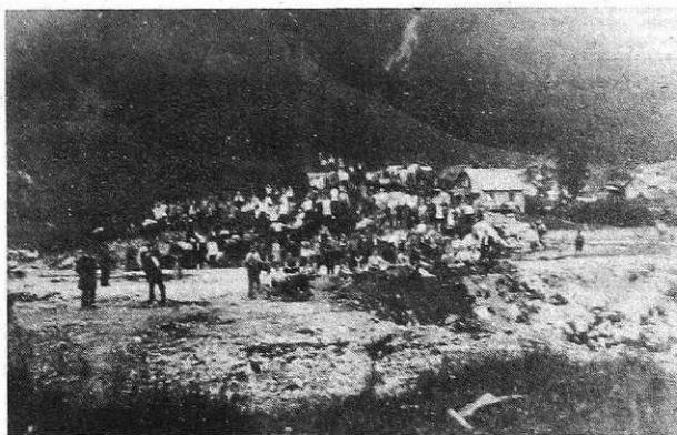
Gradnja nogometnega igrišča Borca
