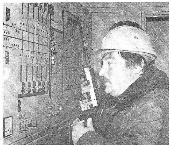
Pred komandno ploščo elektropeči
