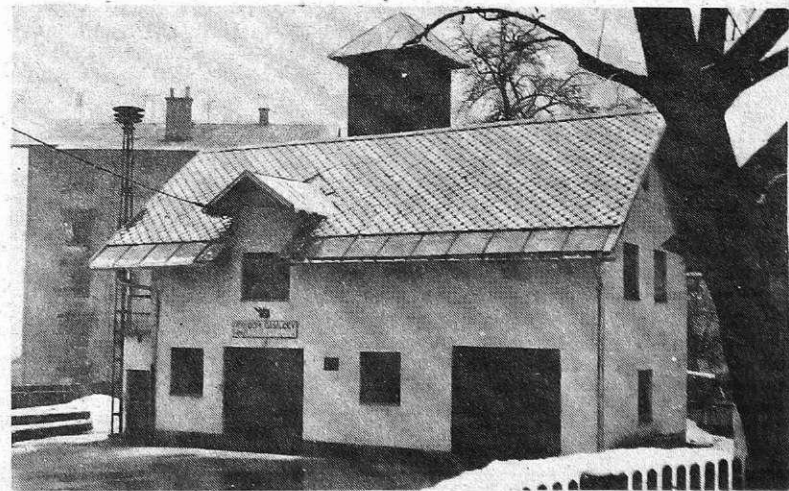
Gasilski dom na Koroški Beli (foto: I. Kučina)
