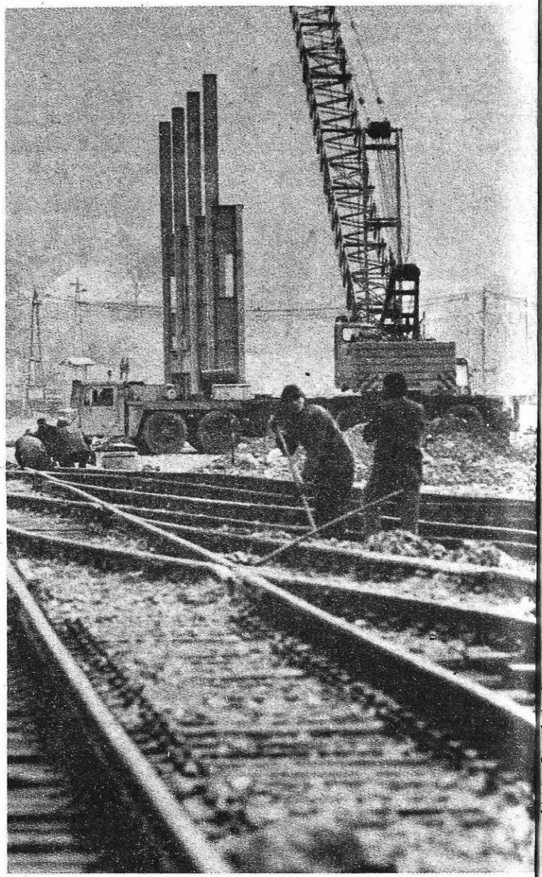
Z gradbišča jeklarnе 2 (foto: I. Kučina)
