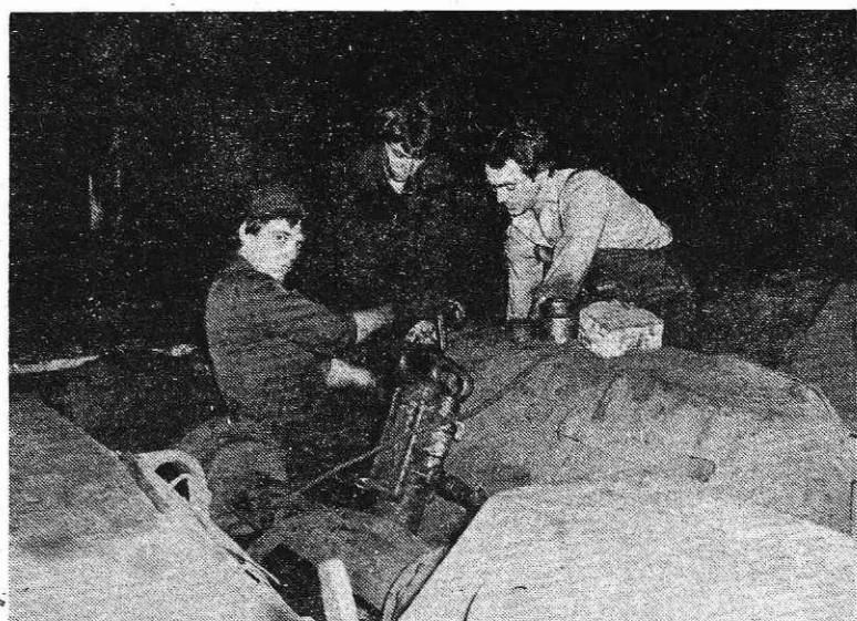
Remont v valjarni bluming štekel (Foto S. Kokalj)
