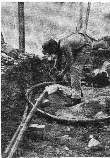
Zalivanje kabljskega stika na kablovodu čez Mežakljo v Radovno (Foto S. Kokalj)
