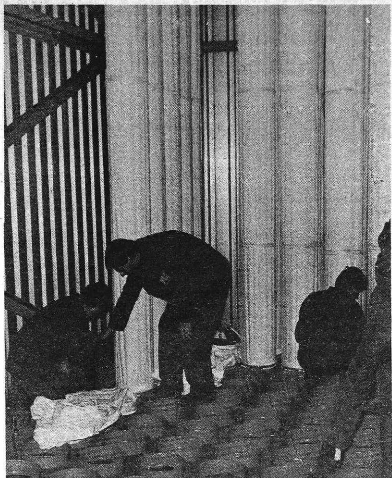
V komore odpraševalnih naprav že montirajo odpraševalne vreče. V vsaki komori je 216 vreč (Foto S. Kokalj)
