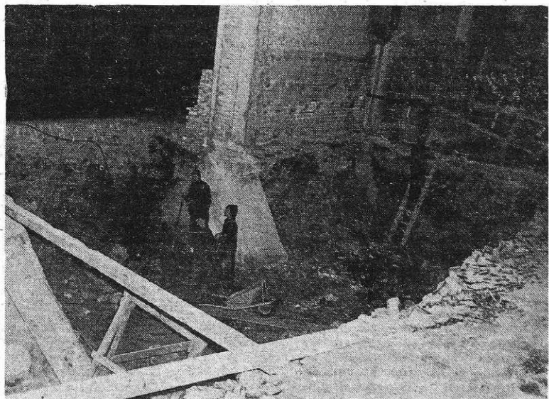
Izkop za 40-tonsko tehtnico v hladni valjarni Jesenice (Foto S. Kokalj)
