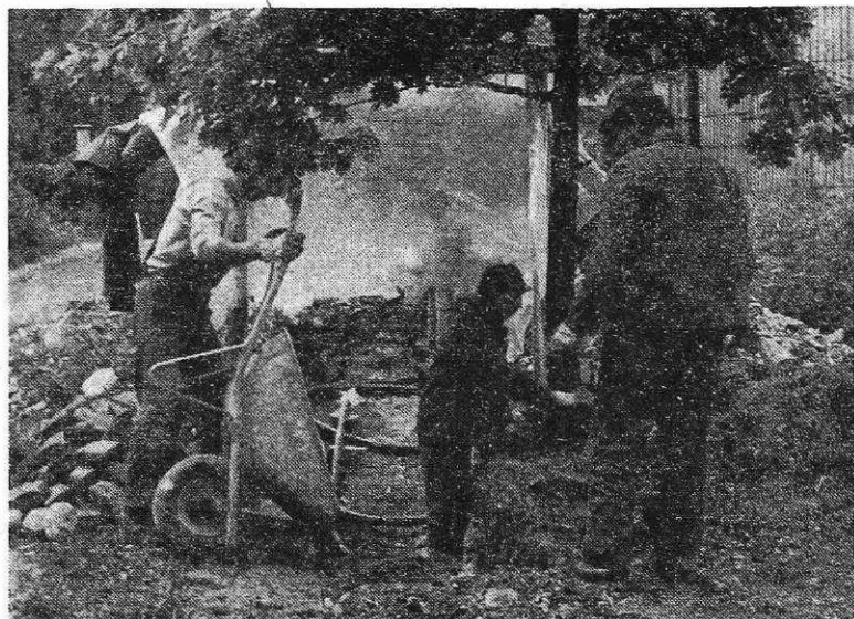
Obnova kabla, ki pelje čez Mežaklo v Radovno (Foto S. Kokalj)
