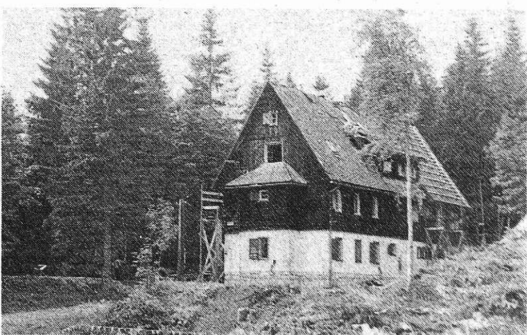
Obnova železarskega doma na Mežakli (Foto T. Konobelj)
