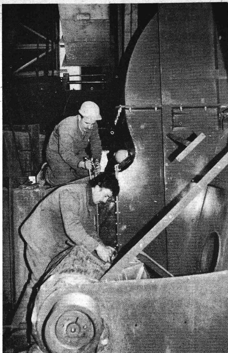
Pri montaži ventilacije na odpraševalni napravi (Foto I. Kučina)
