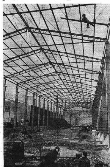
Gradnja nove hale za aglomerirani prašek (Foto I. Kučina)
