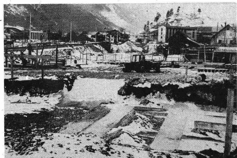
Delavci GIP GRADIS TOZD Jesenice grade med domom TVD Partizan in železniško progo na Koroški Beli tri štirinadstropne stanovanjske stolpce. V vsakem bo 26 stanovanj. Namenjena bodo predvsem prisilcem iz Železarne. Dva stolpca, za katere so temelji že nared, bosta gotova konec tega leta, eden pa bo dožidan prihodnjo spomlad. Vzhodno od tod je predviden še en takšen stolpč. (Foto B. Blenkuš)
