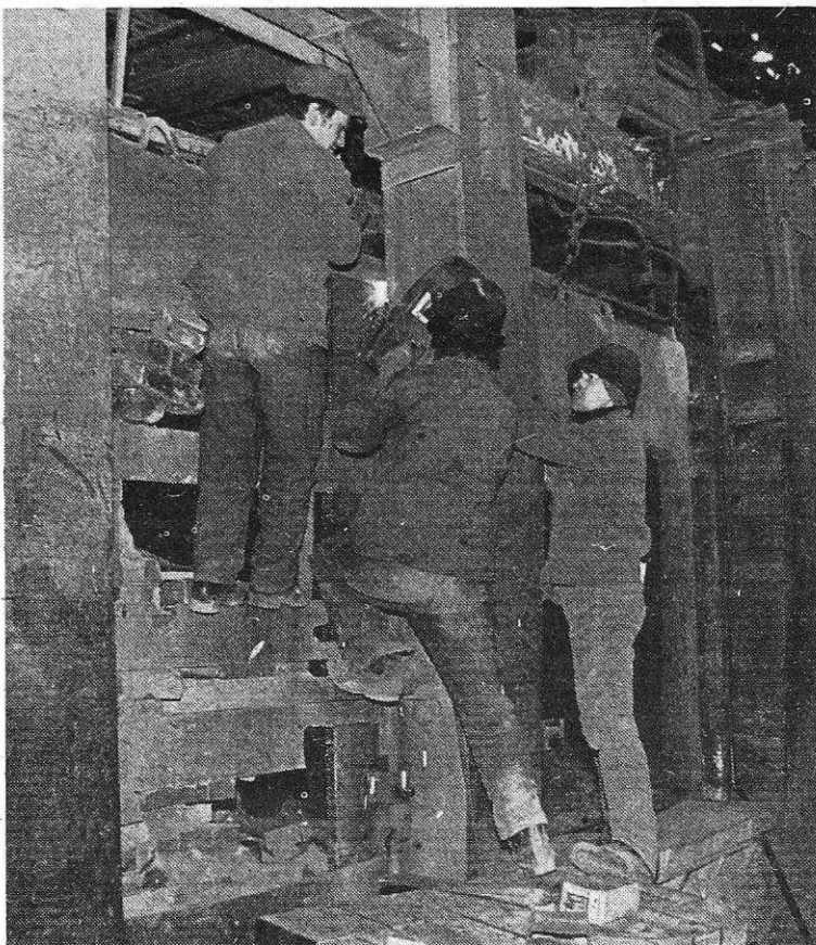
Remont na SM peči (Foto I. Kučina)
