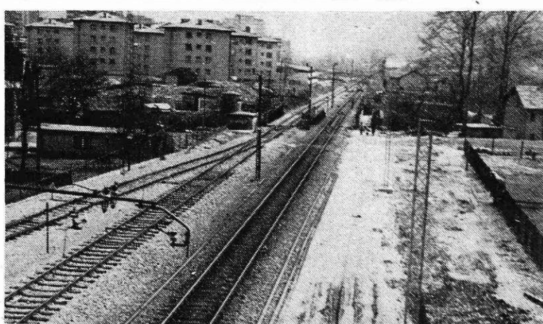
Rekonstrukcijska dela na koroški progi (Foto B. Blenkuš)
