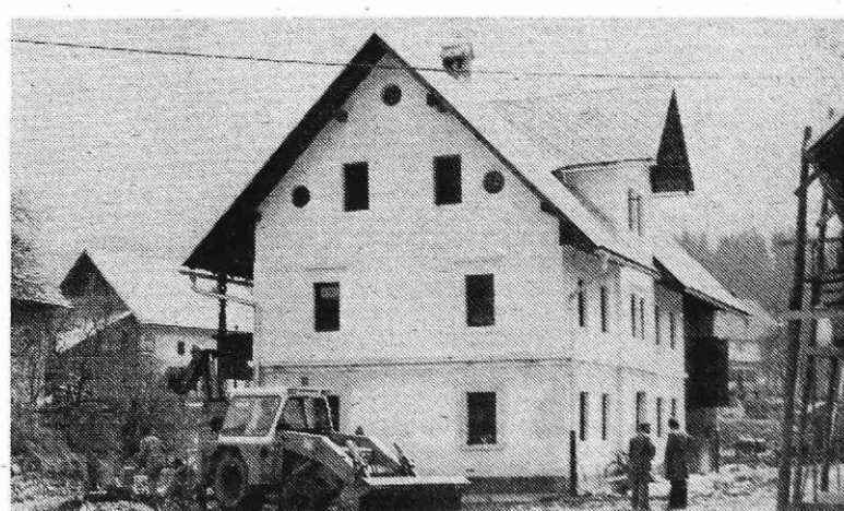
Obnovljena Godčeva hiša v Bohinju (Foto B. Blenkuš)
