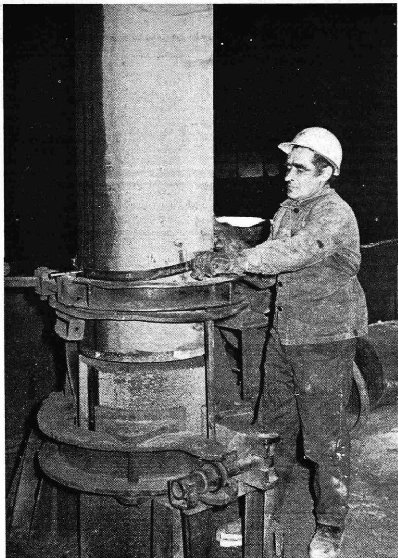
Sodelavec v elektrojeklarni
