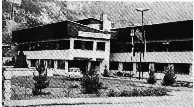
V soboto, 14. oktobra, so v Mostah odprli novo upravno zgradbo Elektro Žirovnica. Slavnostni govor je imel vodja kolektiva Janez Pšenica, na slovesnosti pa je igral pihalni orkester DPD Svoboda Lesce. (Tekst in foto B. Blenkuš)
