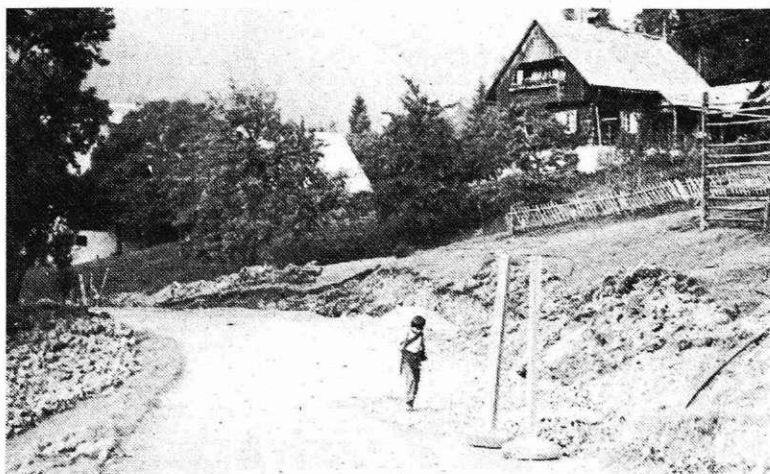
Rekonstrukcija ceste v Planino pod Golico (Foto B. Blenkuš)
