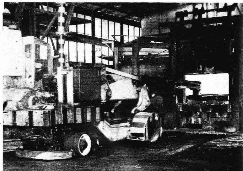
Zakladanje krožne peči v valjarni debele pločevine
