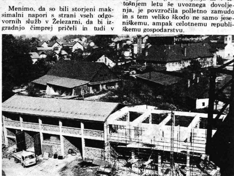
Gradnja skladišča za gradbeni oddelek
