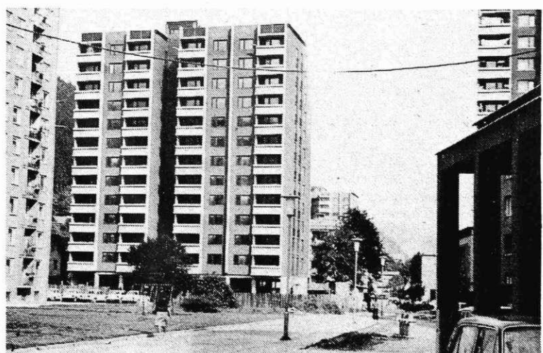
V začetku jeseni bo nared stolpnica S 2 na Plavžu. V njej bo 84 novih stanovanj. (Tekst in foto B. Blenkuš)
