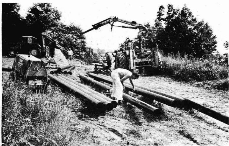
Najtežja odseka pri graditvi cevovoda za zemeljski plin sta vsekakor kanjon Završnice in Soteska nad akumulacijskim jezerom hidrocentrale Moste. V Završnici delavci Vöest Alpina z Dunaja, ki gradijo ta del, spuščajo cevi ob stenah skoraj navpično do dna strune. Sotesko pa bodo obšli tako, da bodo speljali cevi za njo zelo strmo čez hrib. Predvidevajo, da bodo ta dela trajala nekaj več kot mesec dni. (Tekst in foto B. Blenkuš)
