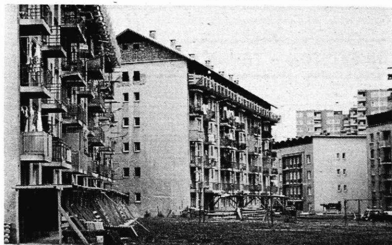
Dela pri nadzidavi stanovanjskih blokov na Cesti revolucije dobro napredujejo. Delavci SGP Gradbinc bodo naredili našim pogojem ustrezne strehe, s tem pa bodo v štirih blokih z nadzidavo pridobili 18 novih stanovanj v novem, petem nadstropju. (Tekst in foto B. Blenkus)
