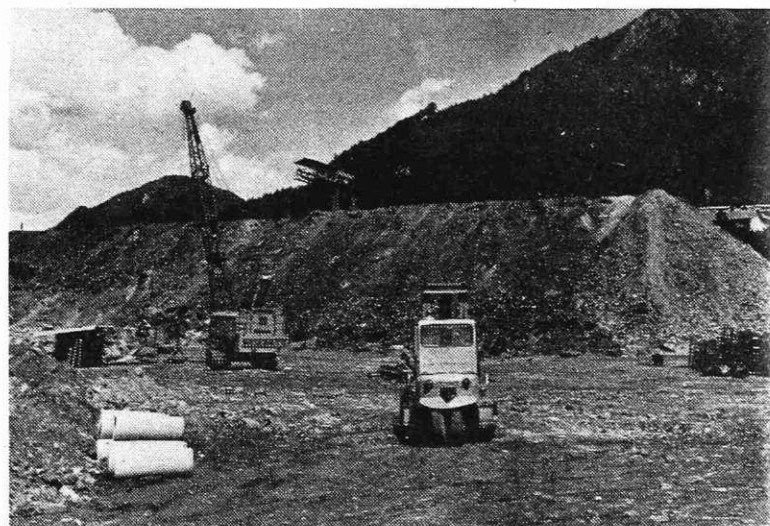
Mobilno dvigalo z magnetom Wesserhütte tip 1800
