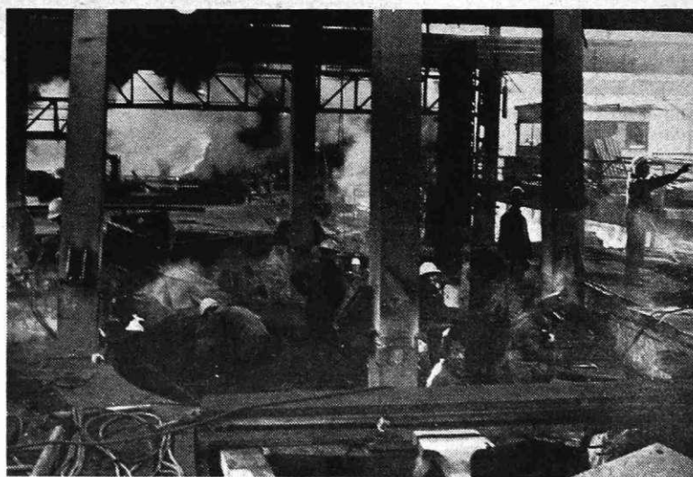
Remontna dela na plavžu II
