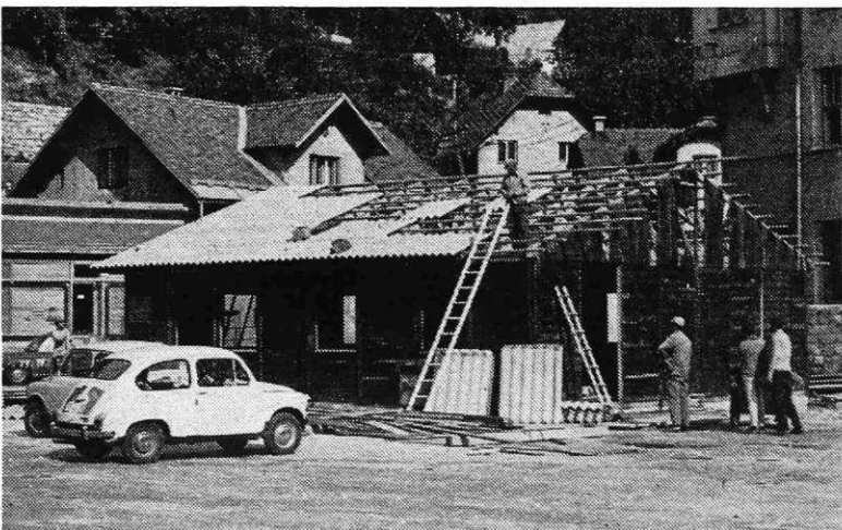
Delavci ŠGP Gradbinec Kranj - TOZD Jesenice, so pred kratkim pričeli s pripravljalnimi deli za zidavo stanovanjskih stolpnici v centru II na Jesenicah. Po srednjeročnem družbenem planu razvoja občine Jesenice se predvideva, da se bo do konca leta 1980 na prostoru med carinarnico in Viatorjem zgradilo nekaj več kot 400 stanovanj. V stolpnici, ki jo bodo v kratkem začeli graditi zahodno od poslopja carinarnice, bo predvidoma 84 stanovanj. (B.)
