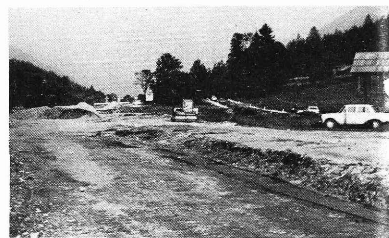
Delavci cestnega podjetja Kranj od začetka avgusta naprej rekonstruirajo glavno cesto od Kranjske gore do Podkorena. Med deli so staro cesto na tej razdalji zaprli, promet pa poteka po asfaltirani obvoznici mimo hotela Kompas, bencinske črpalke, pri nekdanji čuvarnici zavije na traso nekdanje železniške proge, gre za bencinsko črpalno Podkoren in pri Ekarci zavije na novi most čez Savo. Graditev bo veljala nekaj nad sedem milijonov din, financira pa jo republiška skupnost za ceste. Novi del ceste bo verjetno nared sredi jeseni. (B.)
