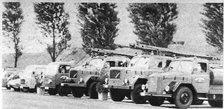
Naši gasilci in reševalci se pripravljajo na proslavo 95-letnice gasilske in reševalne enote Železarne. Ob tej priliki bodo v avgustu pripravili razstavo orodja in naprav, ki so jih doslej uporabljali za gašenje požarov. Na sliki del opreme naše gasilske in reševalne enote. (B.)
