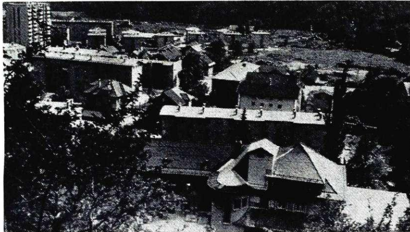
Gornji Plavž — v desnem kotu se vidijo začetna dela pri gradnji šolskega centra Plavž
