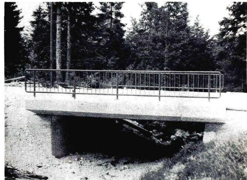
Letos pomladi so porušili stari in dotrajani leseni most čez Savo pri smučarskih skakalnicah v Planici. Na istem kraju pa so postavili novega in večjega. Novi most je iz železobetona, je bolj širok in prenese večjo obremenitev. Na mostu so postavili tudi železno ograjo, s katero so polepšali videz mostu. Čez novi most je sedaj promet varnejši in tudi hitrejši, saj je usposobljen za srečavanje dveh večjih vozil. A. K.
