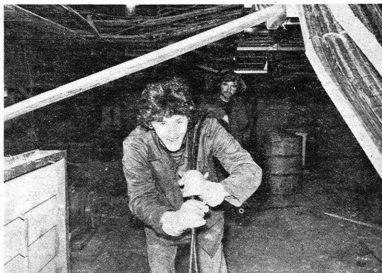
Vlečenje električnega kabla pri montaži tretje žile v valjarni žice
