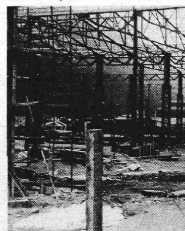
Dela pri postavitvi novega pokritega skladišča trgovskega podjetja Universal na Plavškem travniku dobro napredujejo. Poleg pokritega skladišča, ki bo imelo nekaj nad 7.000 kv. metrov površine, gradijo tudi novo upravno poslopje. Gradbeno delo opravljajo delavci SGP Sava, jekleno konstrukcijo pa so izdelali in jo montirajo delavci Metalne Maribor. Predvidevajo, da bo novo skladišče nared spomladi.
