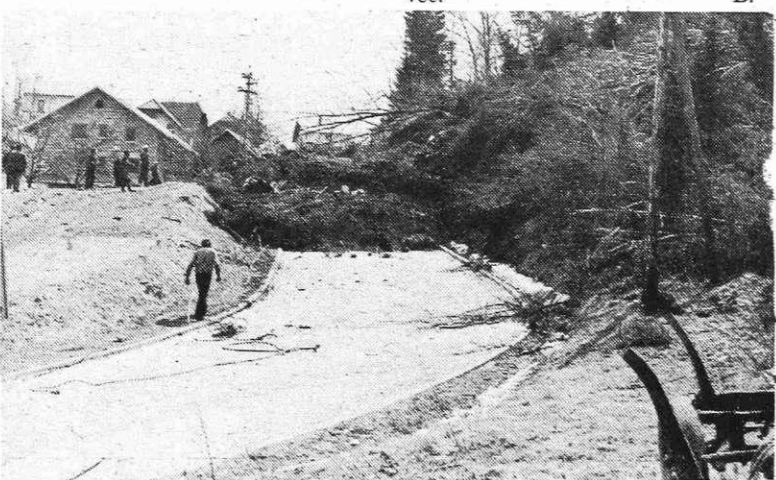
Zemeljski plaz na Blejski Dobravi je zasul cesto Lipce-Blejska Dobrava in Blejska Dobrava-Poljane
