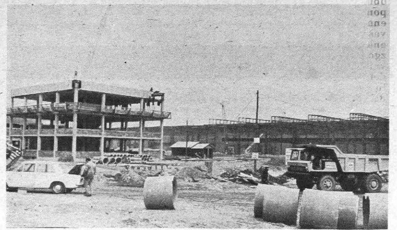
Gradbišče nove hladne valjarne 4. marca
