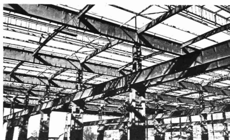
Del konstrukcije nove hladne valjarne (24. 2.)
