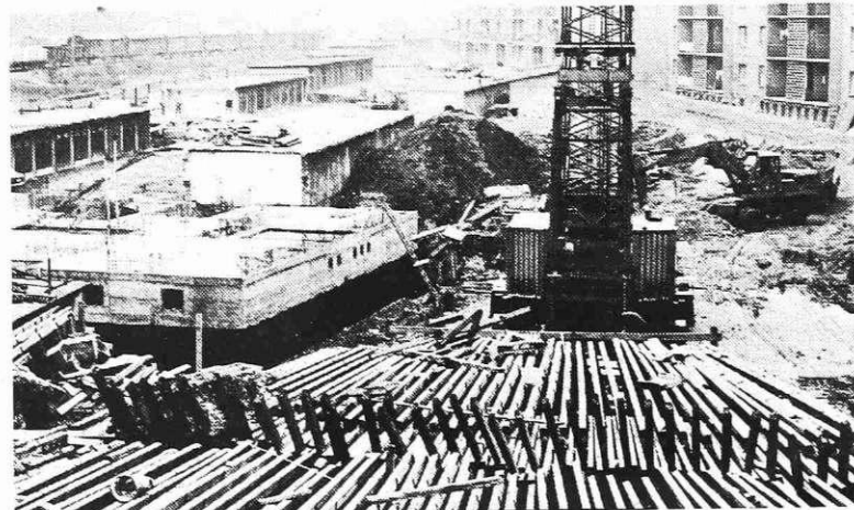
Po dograditvi druge 102 stanovanjske stolpnice, ki stoji ob novem parku na Plavžu, so delavci SGP pričeli graditi dve 50 stanovanjski stolpnici ob železniški progi in 86 stanovanjsko stolpnico za Čufarjem. Predvidevajo, da bodo vse tri gotove približno v enem letu. Na sliki gradbišče dveh 50 stanovanjskih stolpnici v bližini koroške železniške proge. — B.
