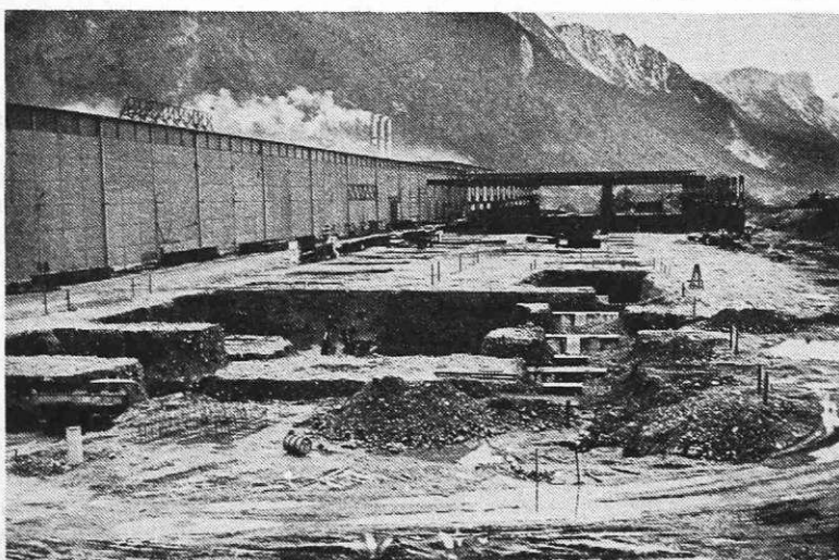
V zadnjem tednu na gradbišču nove hladne valjarne
