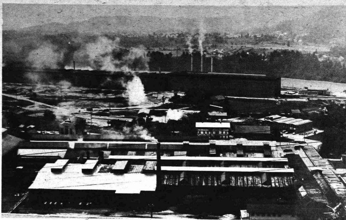
Valjarne Javornik, v ozadju valjarna Bela z gradbiščem nove hladne valjarne
