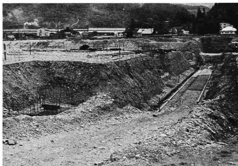
Temelji za energetske kanal.
