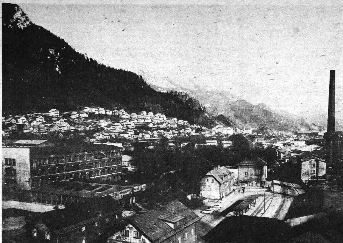
Železarski izobraževalni center, v ozadju novo naselje za progo.
