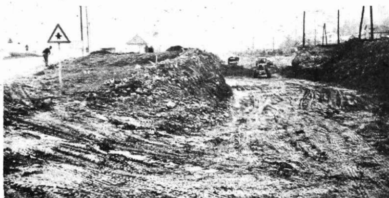
Zemeljska dela na novi trasi ceste Potoki — Javornik uspešno napredujejo.
