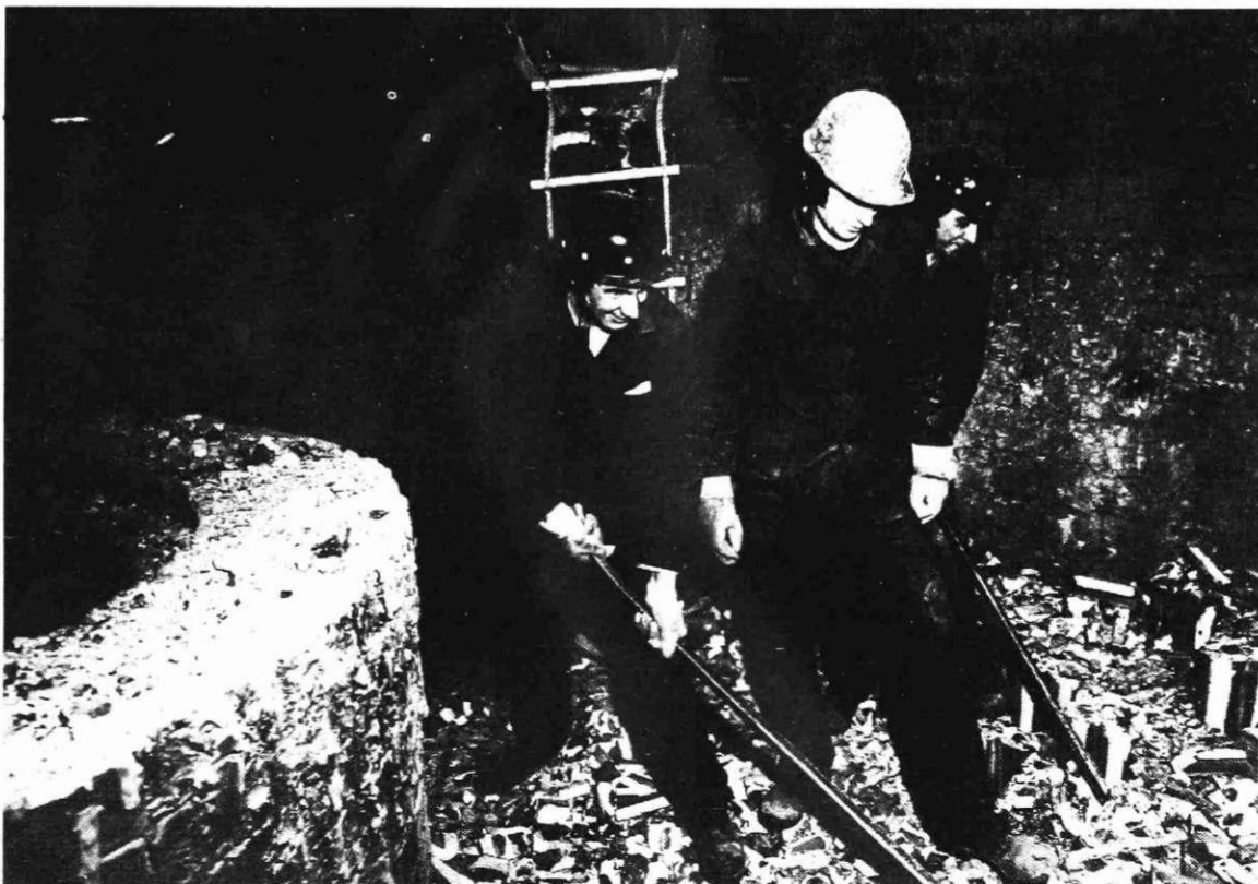
Sodelavci v srcu katperjev.
