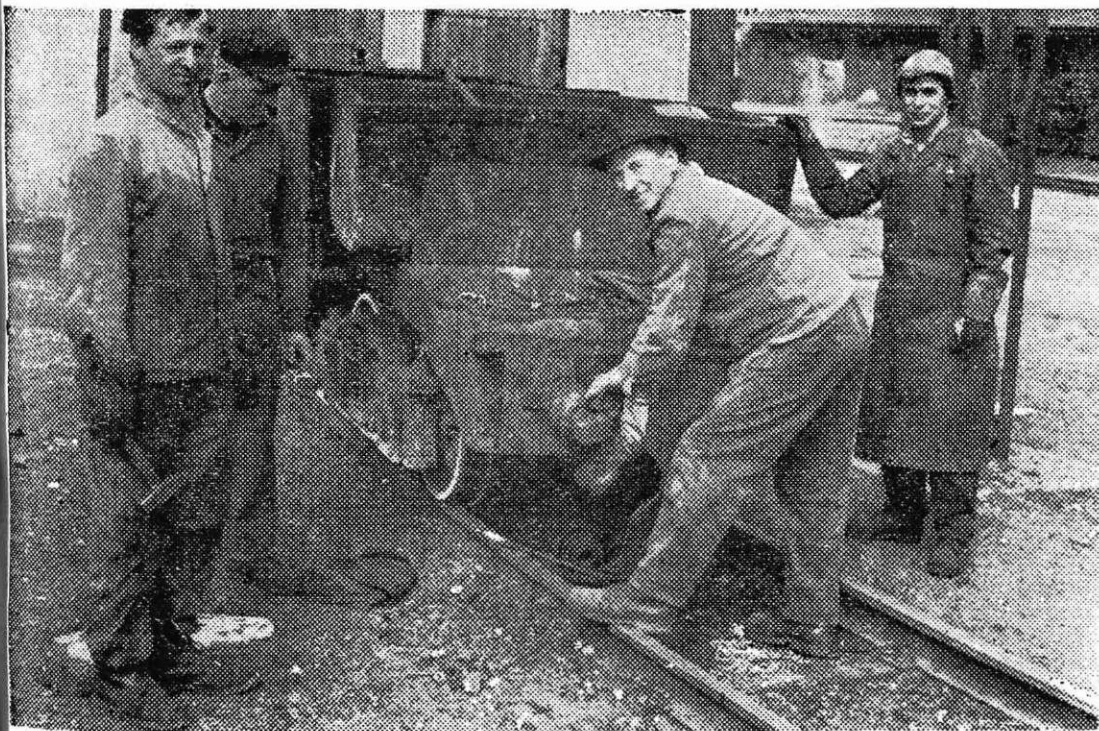
Pri koritnem vozu se je utrgala spénjača. Delavci vozovne delavnice z voza odstranjujejo zlomljen del in nameščajo novega.
