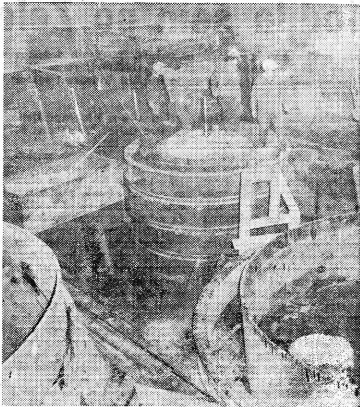
Kalup v jeklolivarni za vsipni zvon železarne Sisak
