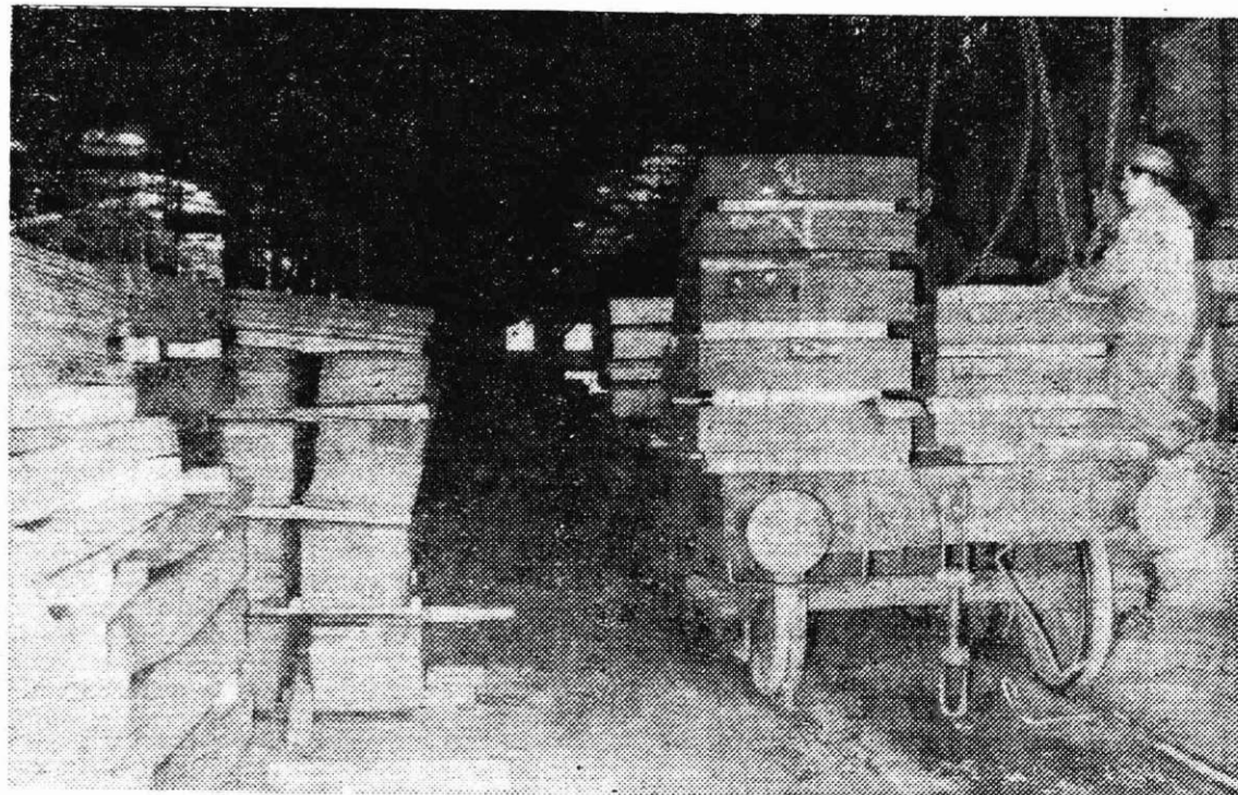
Odprava pločevine v adjustaži štekel na Javorniku
