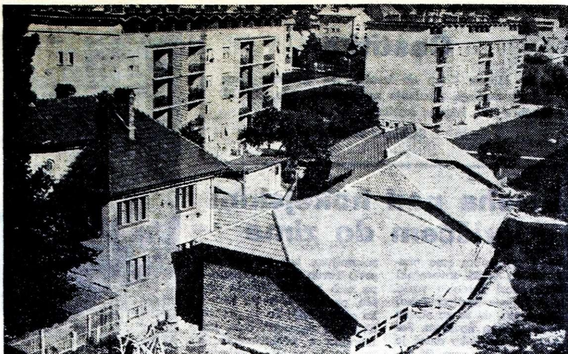
Nova zgradba vzgojno varstvene ustanove A. Ocepke na Pla vžu je pod streho
