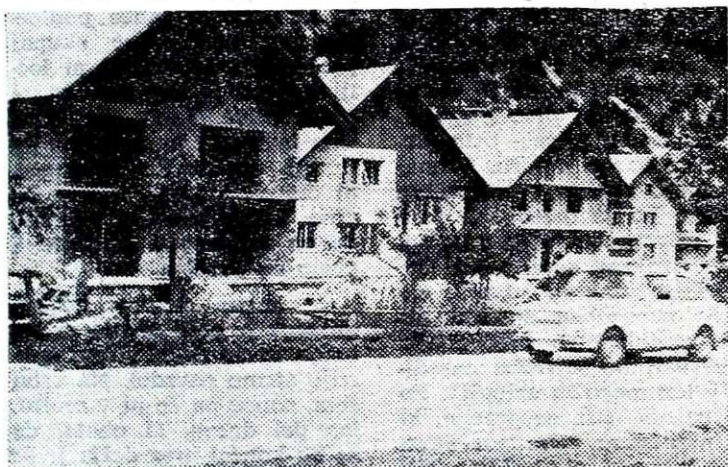
Novo stanovanjsko naselje zahodno od Gozd Martuljka
