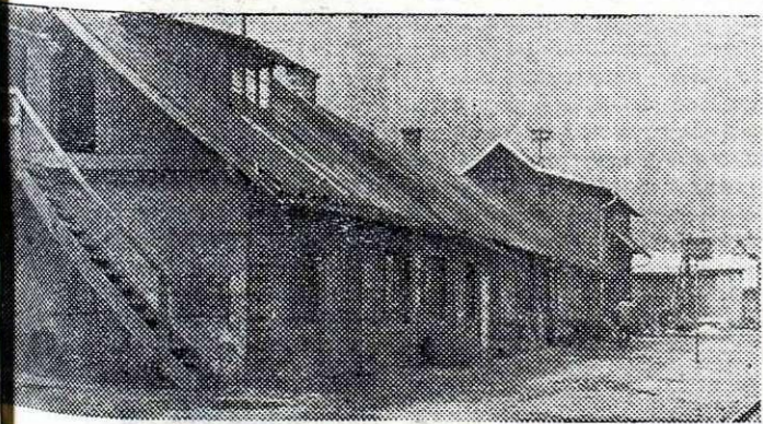
Udi ta baraka je obsojena na rušenje
