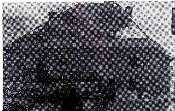
V Kranjski gori bodo porušili nekdanjo sodnijsko poslopje, da bodo uredili avtobusno postajo in parkirišče
