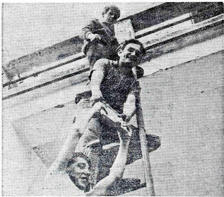
Na Blejski Dobravi so letošnje poletje popravljali ostrešje na stavbi osnovne šole, v kateri je tudi vzgojno-varstvena ustanova in pisarna krajevne skupnosti. Za obnovo stavbe je letos krajevna skupnost namenila milijon in pol S din. Na sliki vidimo mladince, ki so pridno pomagali pri pokrivanju strehe. Strešna opeka je iz rok v roke romala z dvorišča na krov. Složno in z dobro voljo se marsikaj naredi. Sicer pa slika o tem vse pove.
