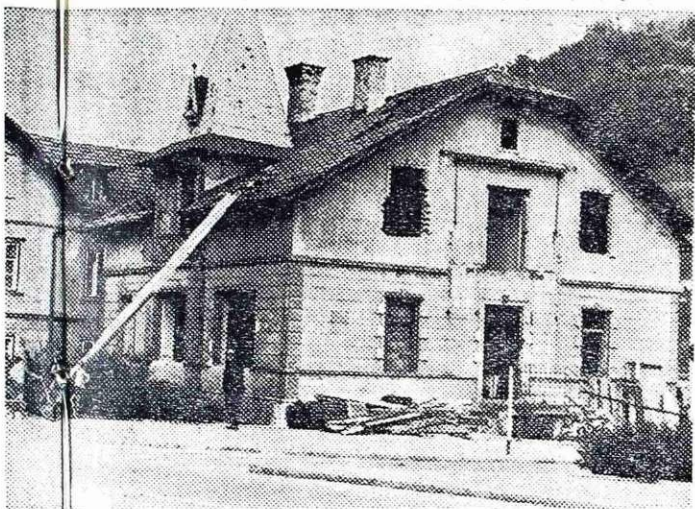
Te dni so začeli na Jesenicah podirati bivšo Kogojev hišo, ki je nekaj mesecev čakala na to
