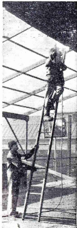
Montaža tople zavese pred vhodom v valjarno 2.400
