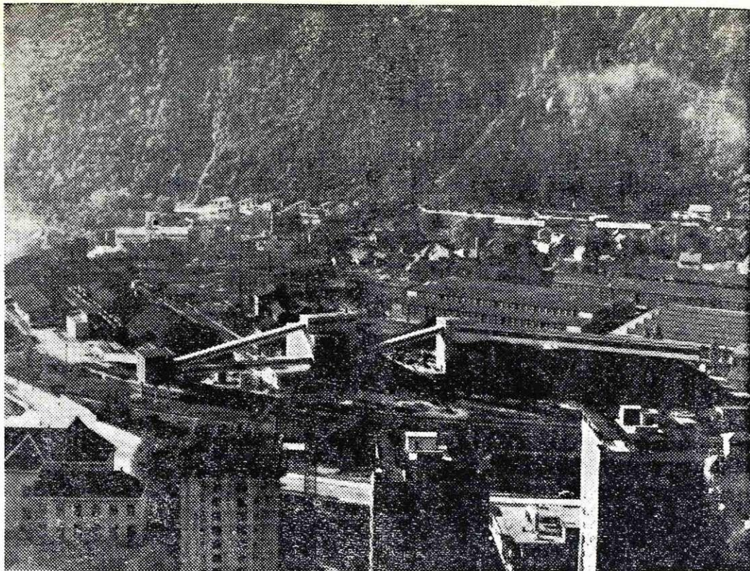
Gradbišče I. in II. faze nove aglomeracije
