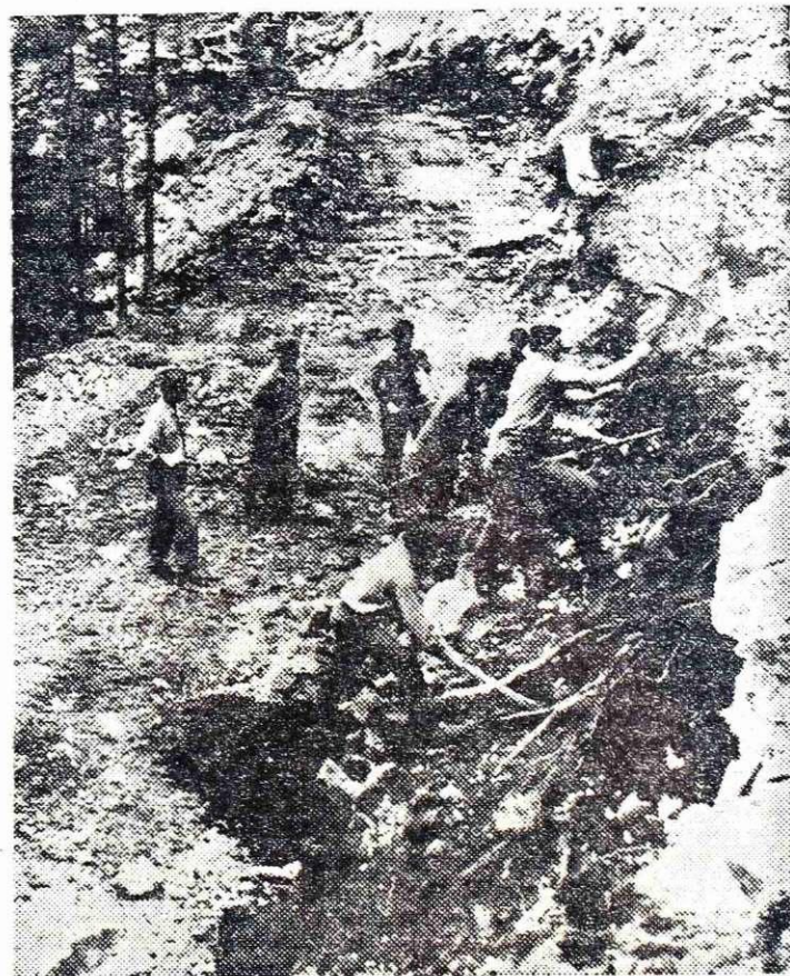
Gradnja ceste v Javorniški rov
