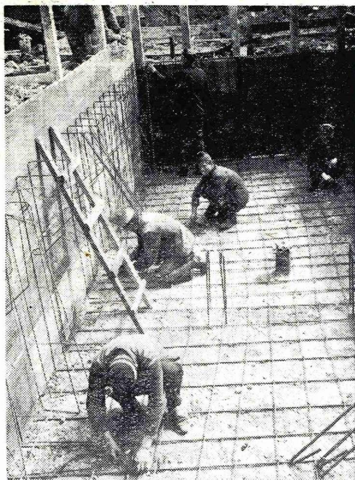
V novi vozovni delavnici je vse pripravljeno za betoniranje plošče, na kateri bodo pozneje popravljali vagone in lokomotive.
